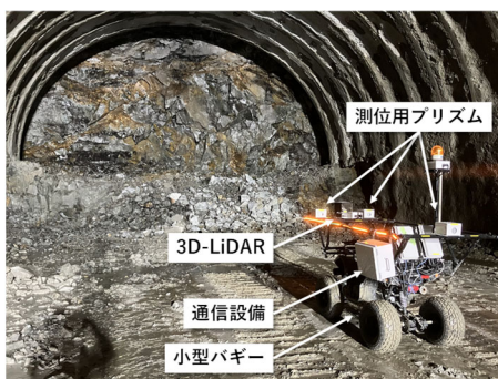
図-1 掘削形状計測状況
