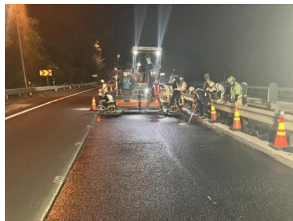
写真-1 施工状況
