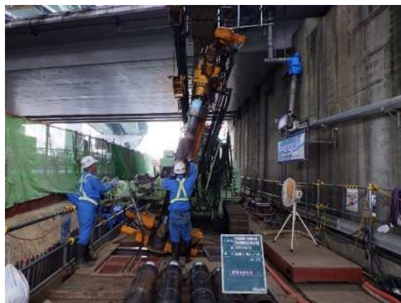
写真-4 道路橋橋台基礎補強（斜杭）
