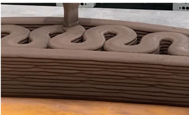
写真-5 ベンチ製作状況
