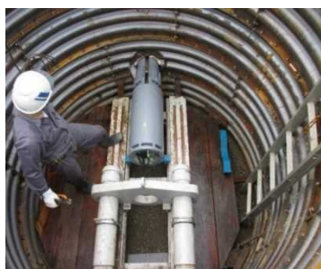
写真-1 地中破碎試験状況
