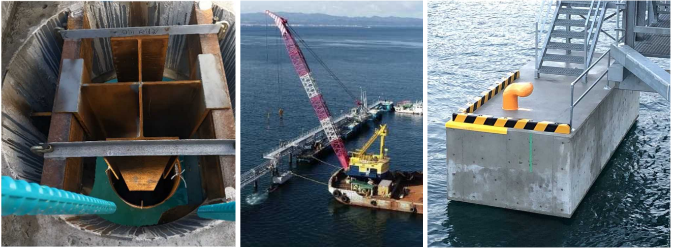
図－7 本工法の適用事例（施工状況と完成状況）
