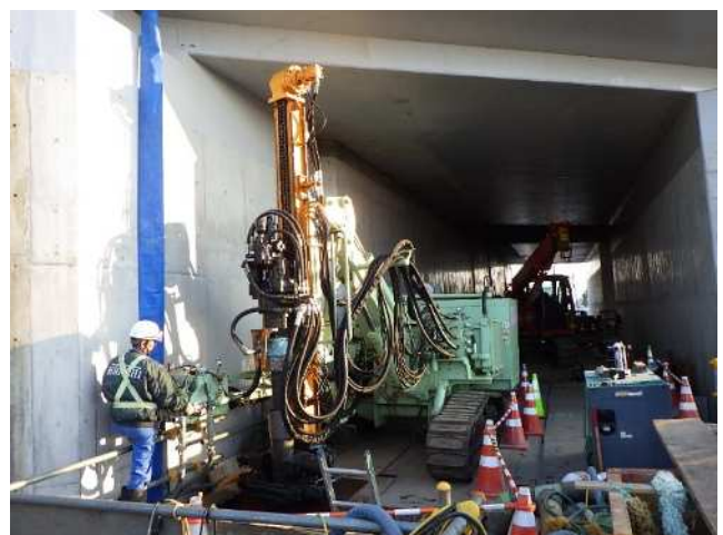
写真-1 杭打設状況
