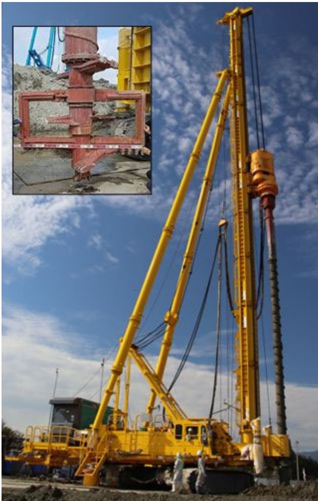
写真-1 S・MIX工法の施工機と攪拌翼
