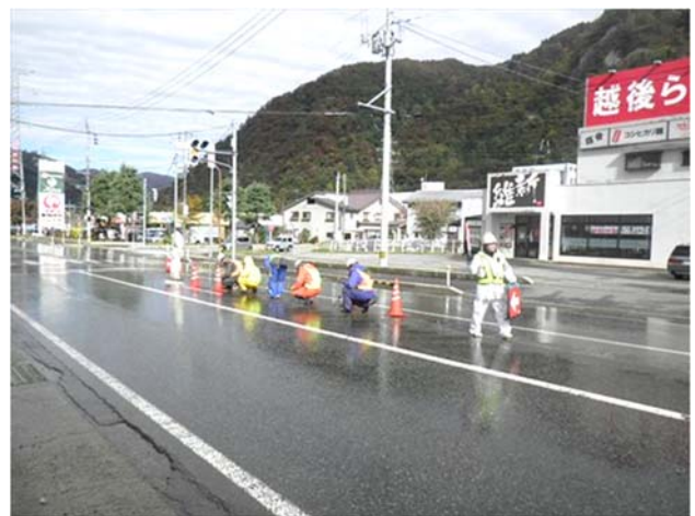
図-1 消雪パイプノズルの点検状況
