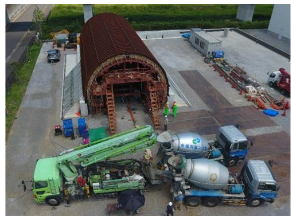
写真-1 実物大施工実験実施状況
