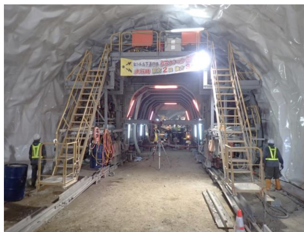
写真-5 コンクリート打込み状況
