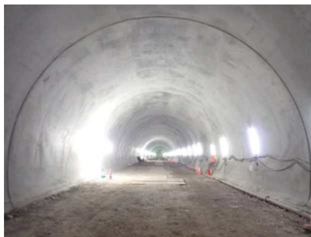
写真-6 覆工コンクリートの出来映え
