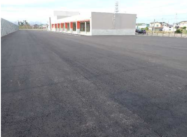
写真-2 除雪基地構内での施工事例
