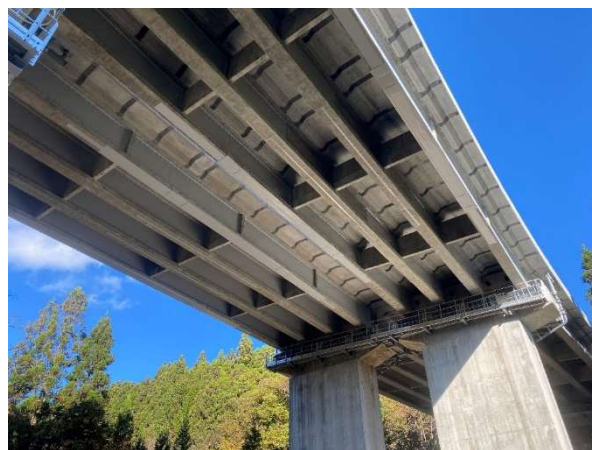
写真－2 PC 合成桁橋の床版取替え完了を確認した。
