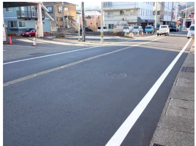
写真-3 消雪パイプ区間での施工事例
