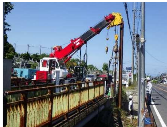
写真-5 新設水管橋橋台基礎
