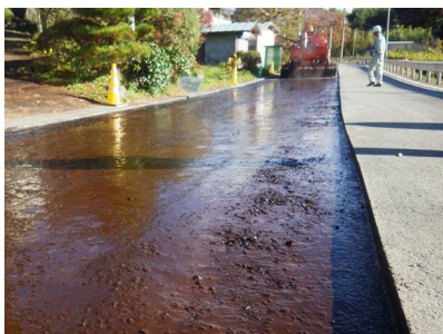
写真-1 PK-3の散布状況
