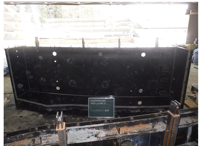
写真-2 鋼製型枠
