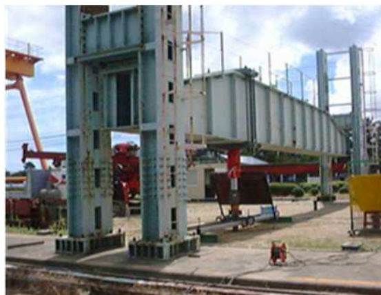
写真-2 鉛直載荷試験の状況
