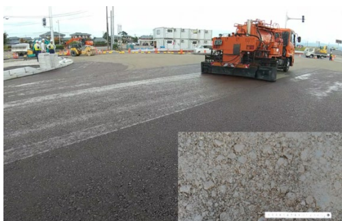
写真-9 プライムファイン散布状況
