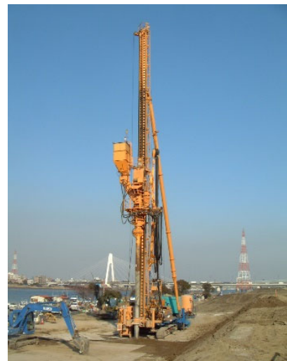
写真-1 静的締固め砂杭工法施工機
