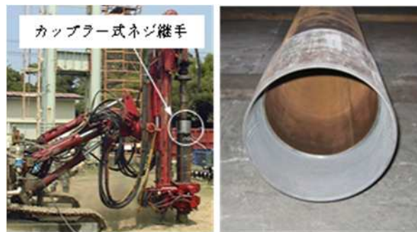
写真-3 機械式ネジ継手（カップラー式ネジ継手）
