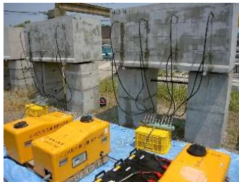
写真-5 内部圧入実施状況
