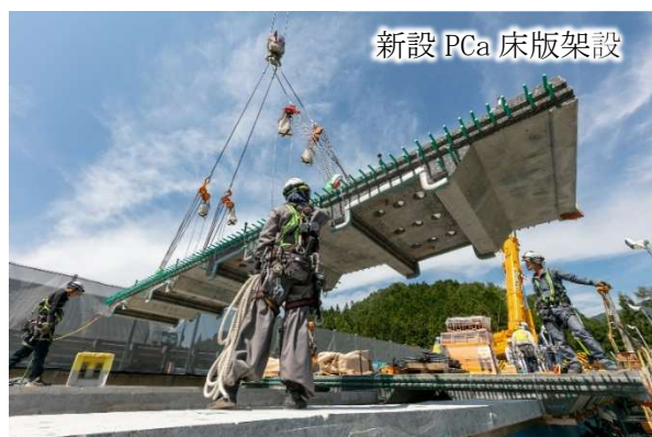
写真－1 PC 合成桁橋の床版取替え状況
