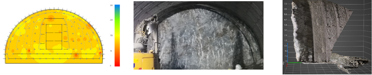
5回目 穿孔エネルギー：31～165J/cm 3 、（平均）125J/cm 3 、穿孔数：129、総装薬数：103.2kg
