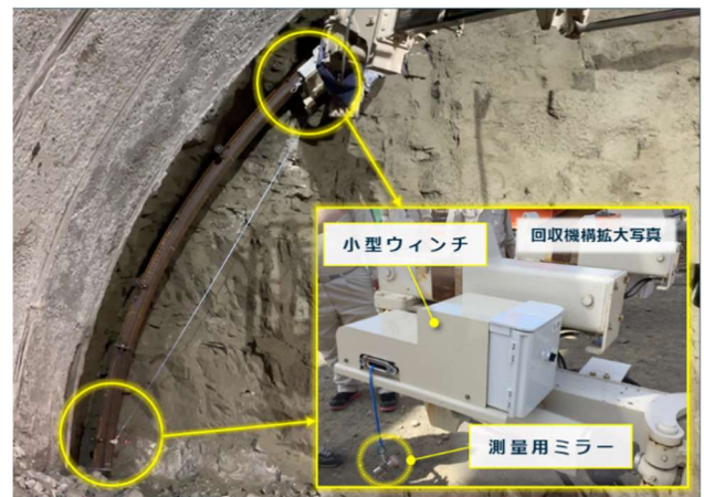
写真-4.5 ミラー回収機構適用状況
