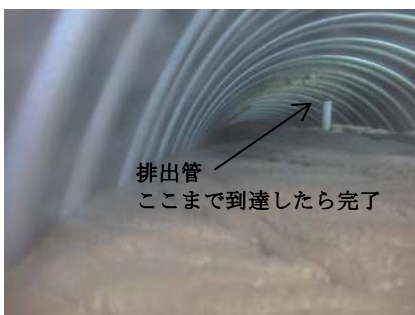
写真－8 無収縮モルタル注入状況
