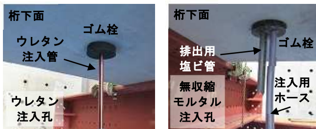
写真－5 注入孔用キャップ（ゴム栓）の設置
