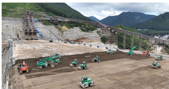
写真一 2023年成瀬ダム自動施工状況
