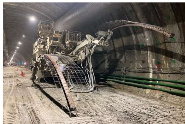
写真-4.3 金網の設置状況
