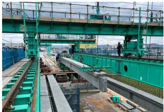
写真-1 桁部材架設状況
