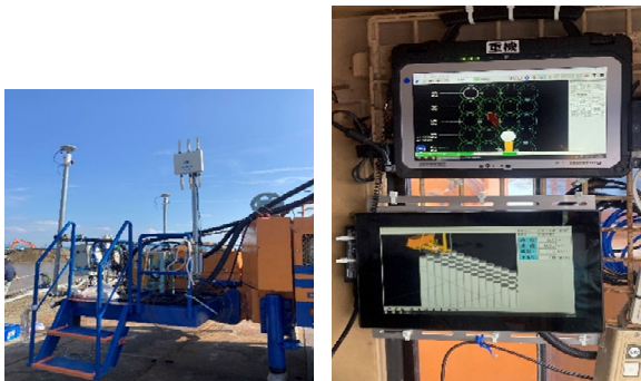
図-10 Tarpos 3D 施工状況
