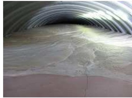
写真－9 無収縮モルタル注入完了状況
