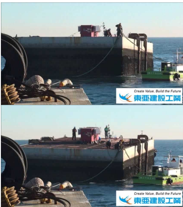
図-1 浮遊ケーソンの動揺状況
