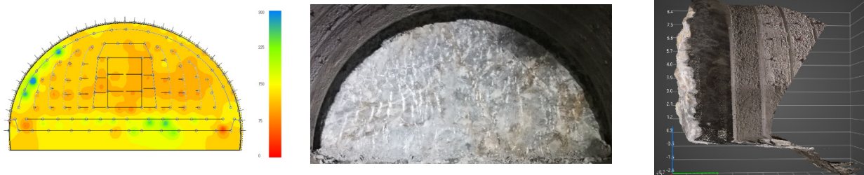
4回目 穿孔エネルギー：86～391J/cm 3 、（平均）123J/cm 3 、穿孔数：136、総装薬数：106.0kg
