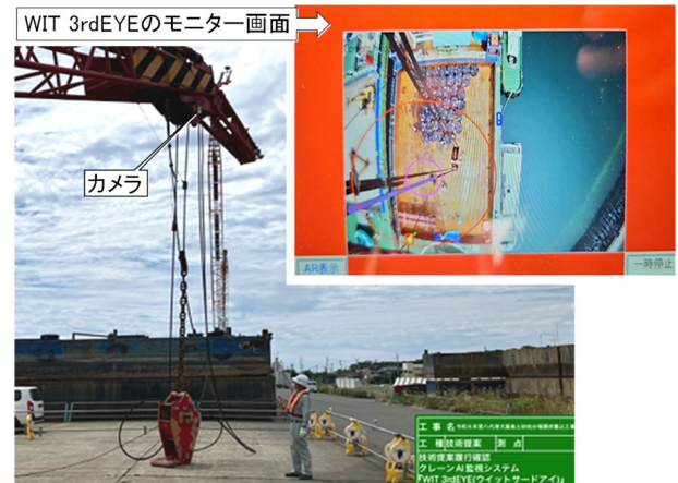
図-8 実現場におけるWIT 3rdEYEの運用状況
