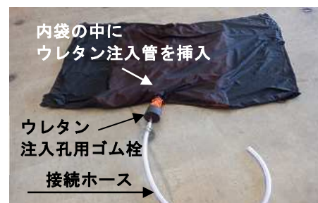
写真-3 ウレタン注入袋の組立状況
