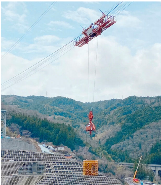
写真-1 ケーブルクレーンによる コンクリート運搬
