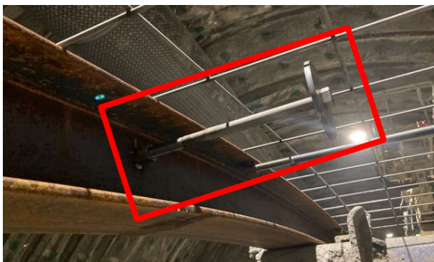
写真-4.4 頭付きアンカーの設置例
