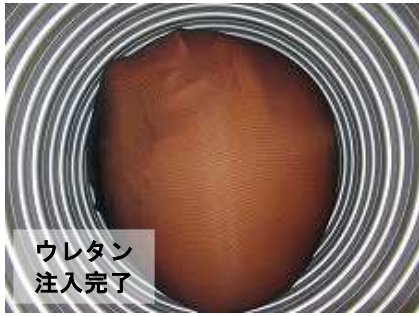
写真－7 ウレタン注入完了状況
