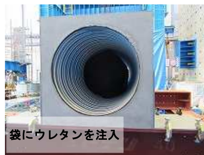
写真－6 ウレタン注入状況
