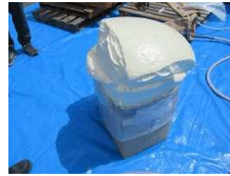
写真-2 UB-WALL工法用ウレタン発泡状況
