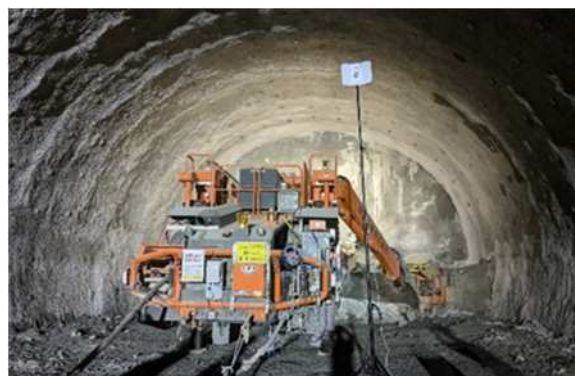
写真-1 屋外長距離通信性アンテナ 配置状況(その1)
