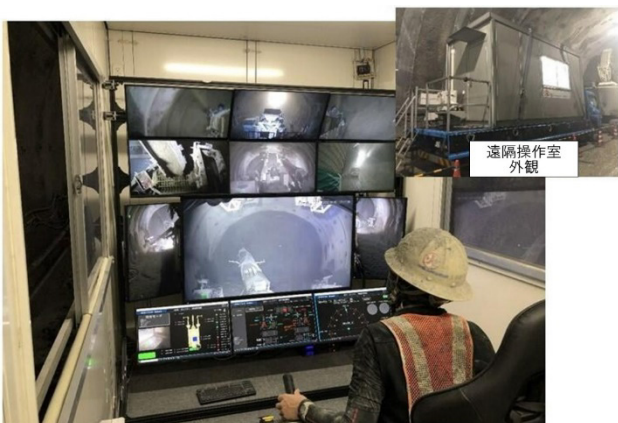
写真－1 吹付けコンクリートの遠隔施工
