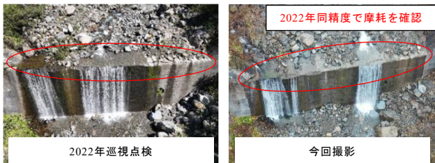
図-3 実証試験結果（別当谷堰堤群）
