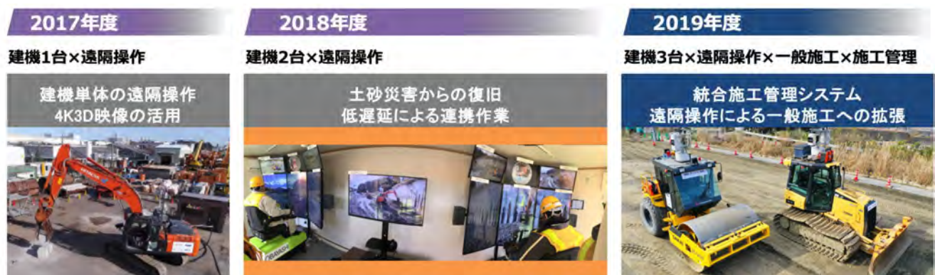
図-1 5G 通信を用いた建機の遠隔操縦実証実験
