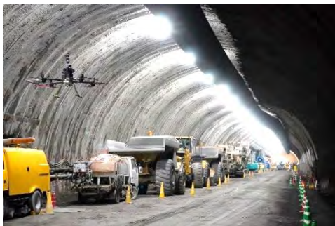
図-4 坑内の自律飛行状況
