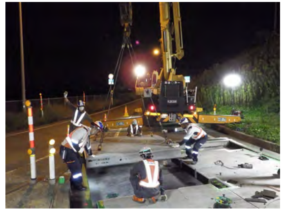
写真 4 融雪用 RC 版設置状況
