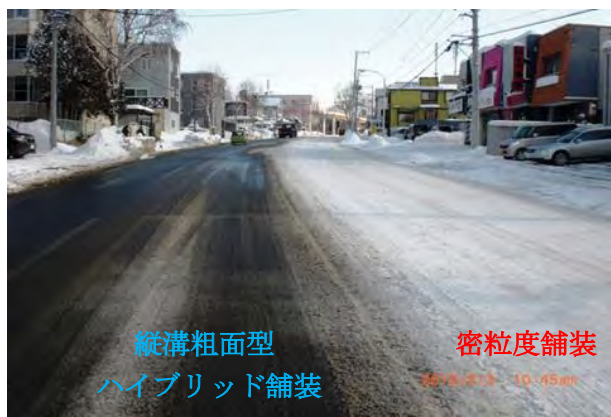
写真－6 施工直後路面露出状況
