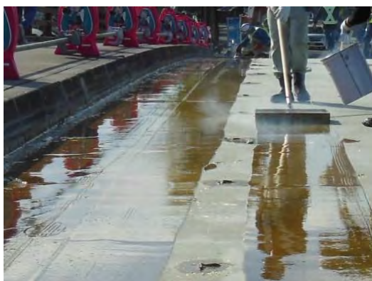
写真－1 接着防水材の塗布状況
