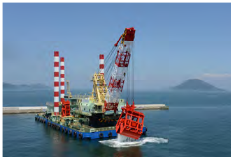
写真－１ グラブ浚渫船「若鷲丸」
