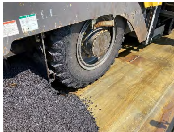
写真－2 接着防水材上での舗設状況
