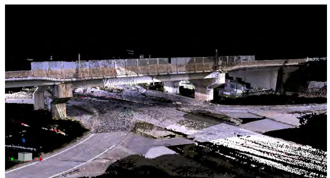
図 2 起工測量による 3D モデル（点群データ）
