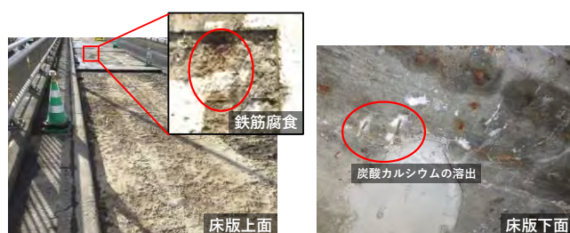
写真－1 施工前の床版の状況
