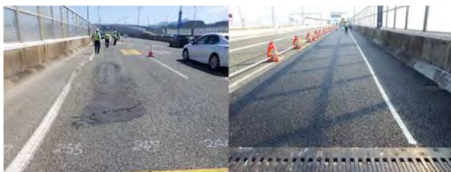
写真－3 施工前後の状況 (左：施工前、右：施工直後)
