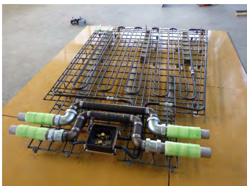
写真1 融雪用RC版の配管・配筋
