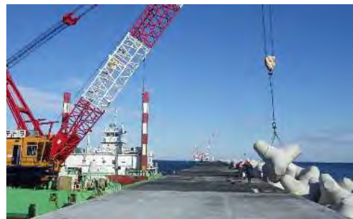
図-1 ブロック据付状況
