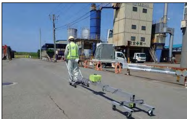
写真-3 縦断プロファイルメータ計測状況
