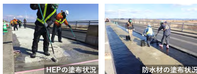
写真－2 施工状況
