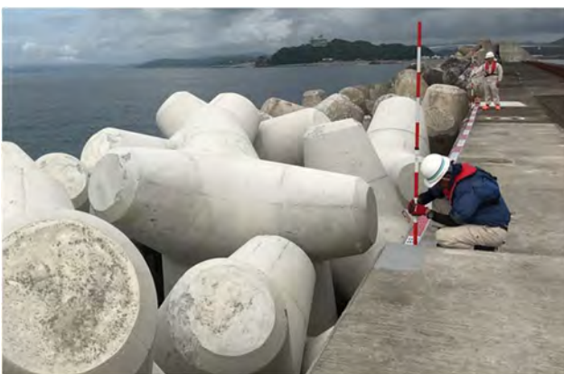
図-1 消波ブロックの出来形計測状況
