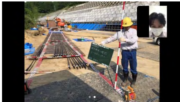
図－9 遠隔臨場による確認状況
