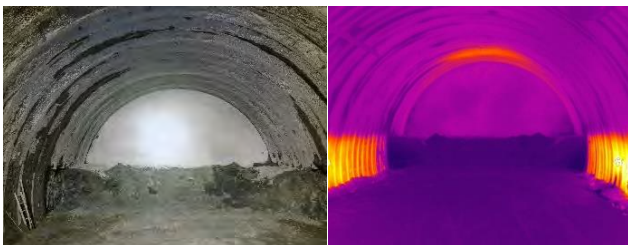
図-6 切羽のワイド画像/熱赤外線画像
