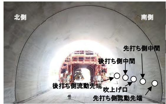
写真-2 コンクリートの仕上がり
