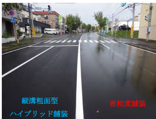
写真-5 施工直後浮き水抑制状況
