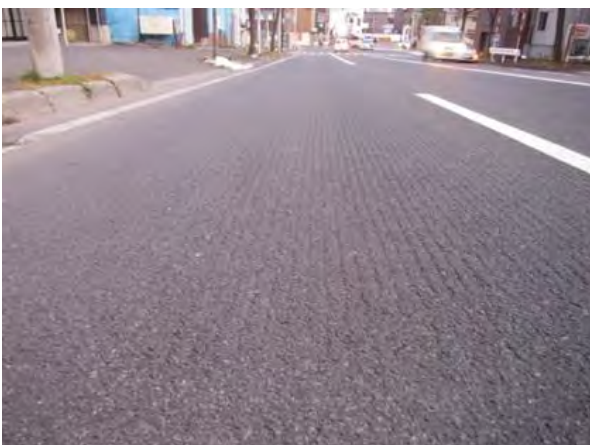
写真-3 施工2年後のFFP路面（札幌市内）
