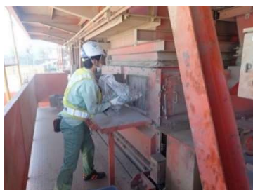
写真－2 添加材投入状況
