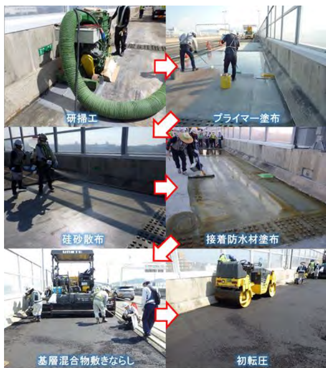
図－4 施工状況
