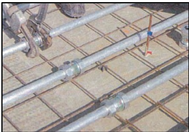
写真-4 LAジョイント継手
