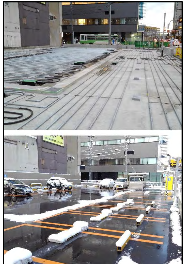
写真－1 井水式無散水融雪施工例
