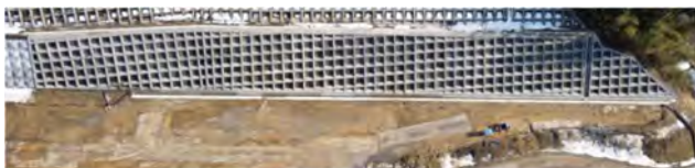
写真-2 令和2年度 完成写真（3工区分）
