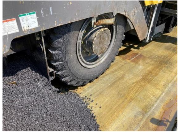
写真-3 接着防水材上の舗設状況
