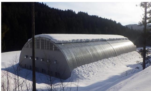
写真3. 3 積雪深 60 cmにおける屋根積雪状況
