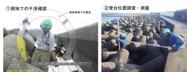
図-1 従来方法による排砂管ルート測量
