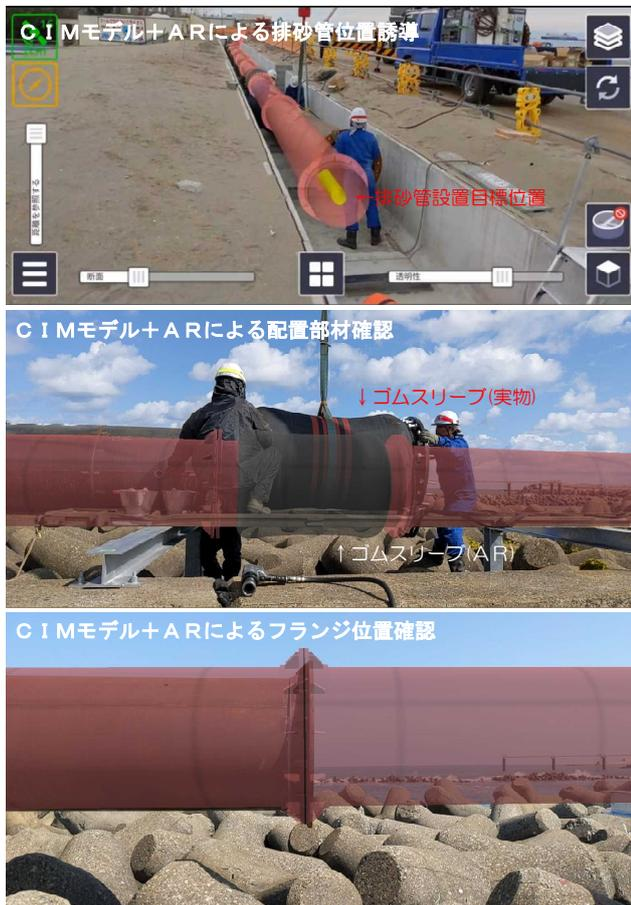
図-6 ARによる排砂管施工管理
