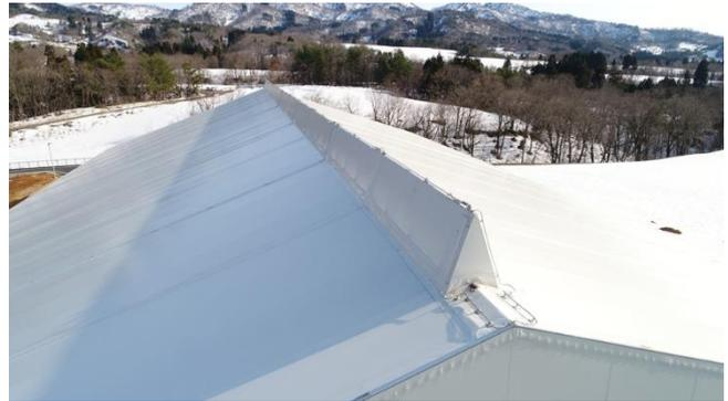
写真2.2 被覆施設(屋根傾斜 35%、雪割)
