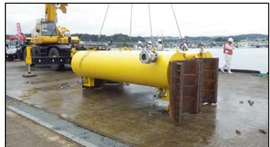
図-9 専用フロータ艀装状況
