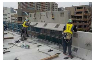
写真-6 EMC 壁高欄の設置状況
