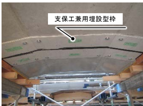
写真-5 支保工兼用埋設型枠
