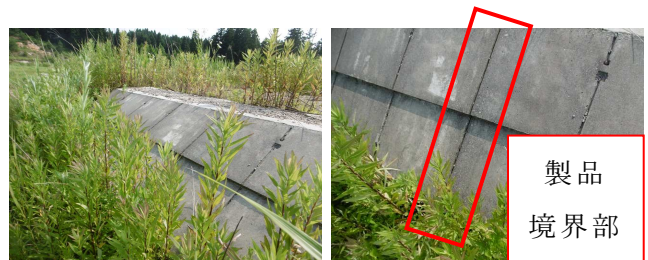
写真-6 防草効果の確認（施工後3年半）
