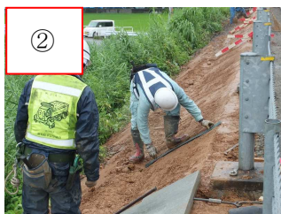
写真-7 防草シート張り付け
