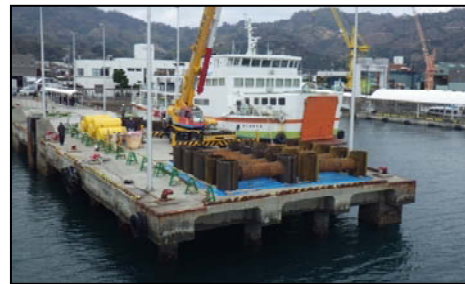
図-14 フェリー岸壁
