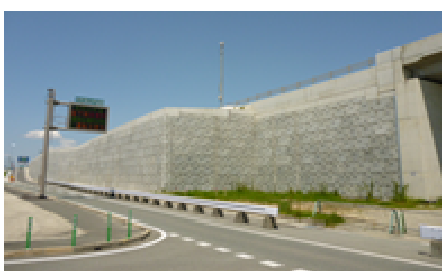
写真-1 補強土壁の外観
