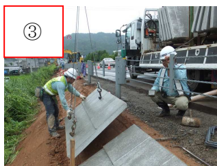
写真-8 製品施工
