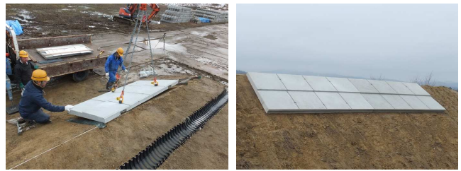
写真-4 施工性の確認と施工完了
