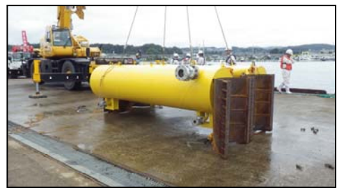
図-9 専用フローター艀装状況
