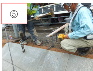
写真-10 天端アンカー鉄筋打込み
