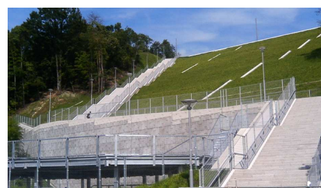
写真-2 補強土壁の外観
