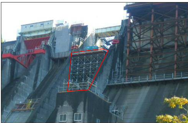
写真-1 パイプ支柱式支保工
