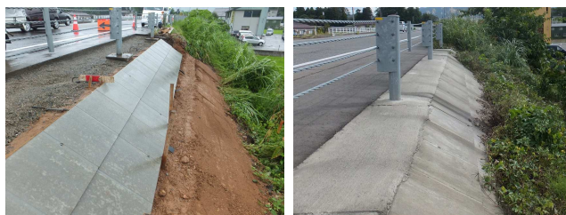
写真-12 施工後の経年変化
