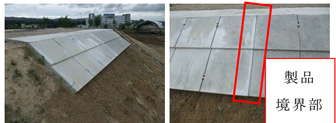
写真-5 防草効果の確認（施工後4ヶ月）
