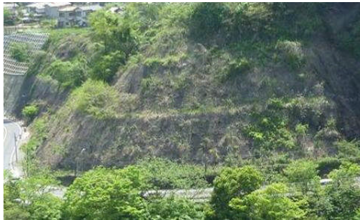
写真-1 吹付工適用例
