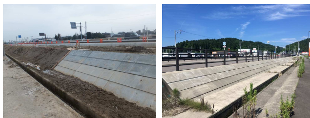
写真-11 施工後の経年変化
