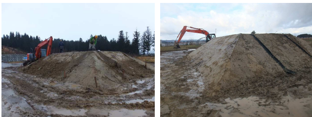
写真-3 盛土造成状況
