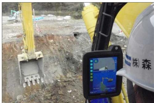
写真-4 切土法面整形の掘削作業状況及びモニター表示状況
