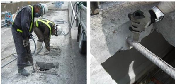
写真-4 コンクリートはつり・PC鋼材露出
