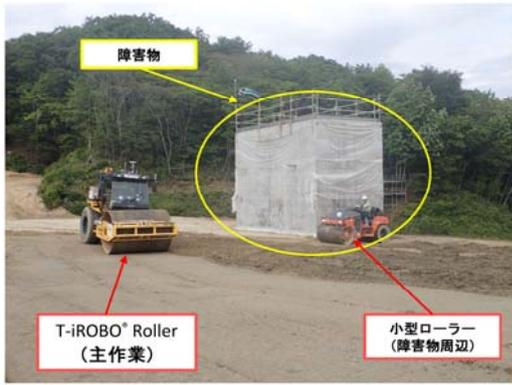
図-13 T-iROBO Rollerによる施工状況
