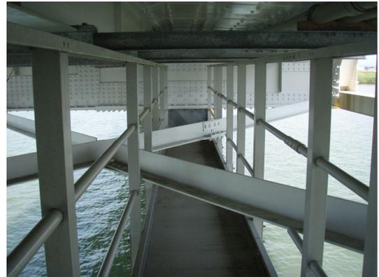
写真-11 手摺設置完了
