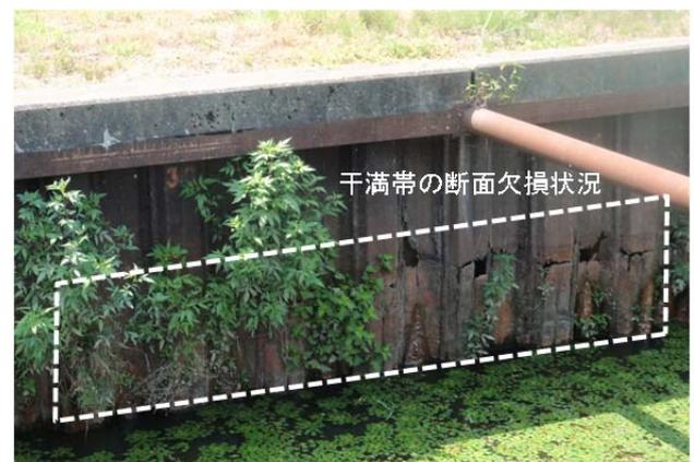
図-1 鋼矢板水路の腐食と断面欠損
