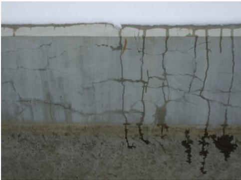
写真-1 PCM 早期ひび割れの例
