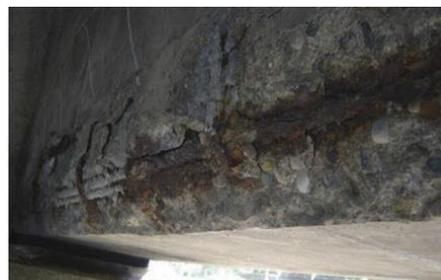
写真-1 主桁鉄筋の腐食状況
