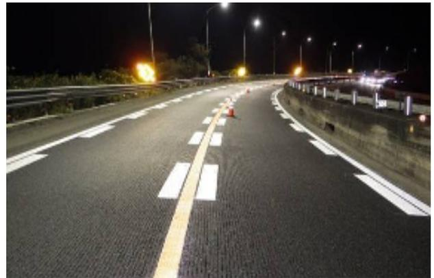
写真-6 大道カーブ FFP 施工後の路面状況
