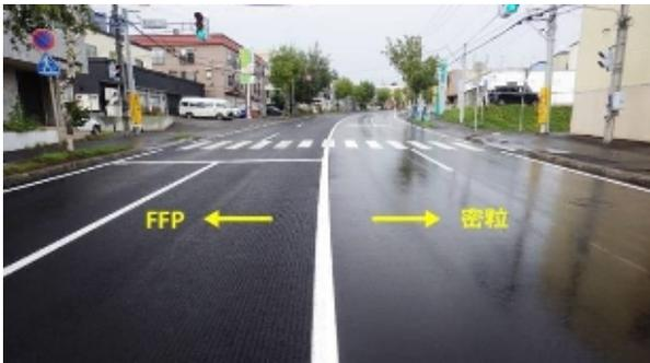
写真-3 浮き水抑制路面状況
