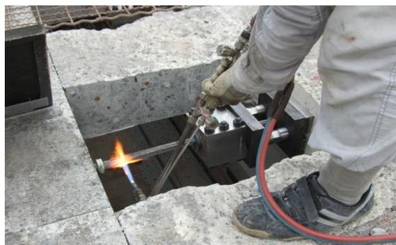
写真-9 PC鋼材の切断
