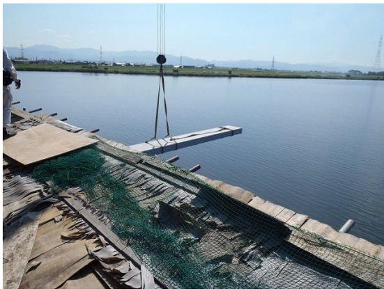
写真-9 桁下の足場への取込み
