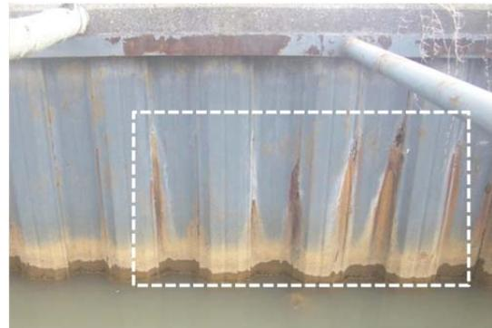
図-2 表面被覆材の再劣化事例
