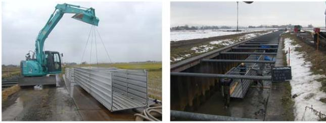
図-8 鋼製組立式仮設水路の設置状況
