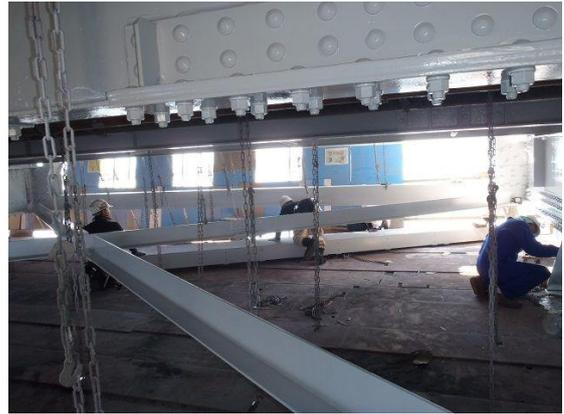
写真-10 桁下の足場への取込み
