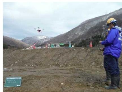
写真-6 UAVによる出来形測定
