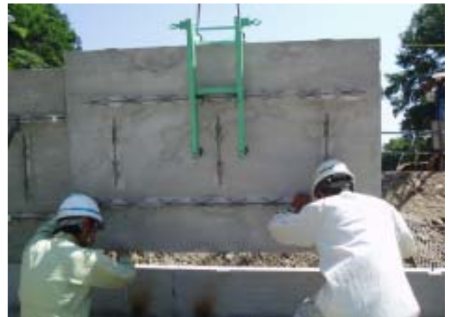
写真－4 パネル据付
