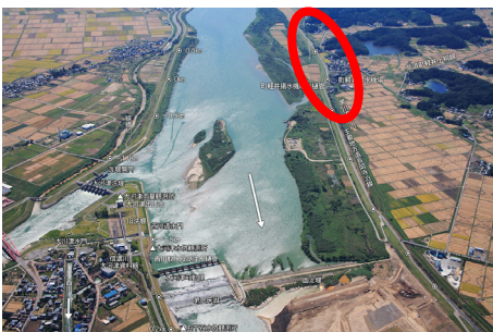
写真－3 施工位置※
