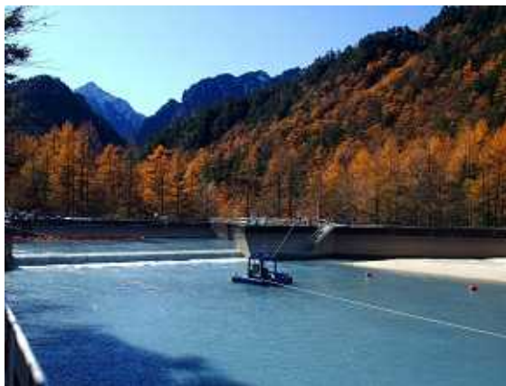
写真-4 マジックボール運転状況
