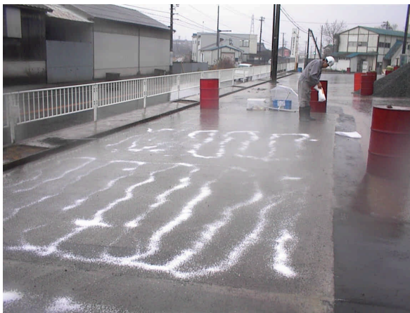
写真-1 試験施工箇所の凍結抑制剤 （塩化カルシウム）の散布状況
