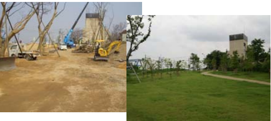
写真—7 覆土・植栽状況
