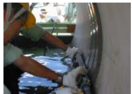
写真－2 内径 1350 での施工機械使用状況
