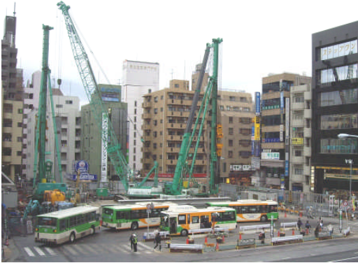
写真－2 施工状況
