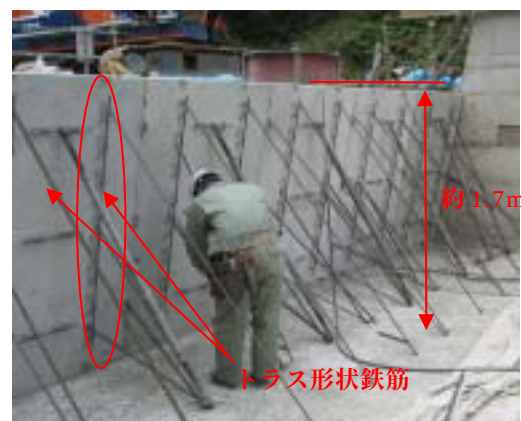
写真－2 施工状況
