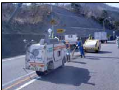
写真－3 切削状況
