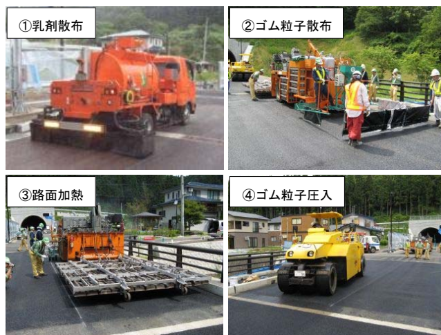
写真-3 ラバーパック E の施工状況
