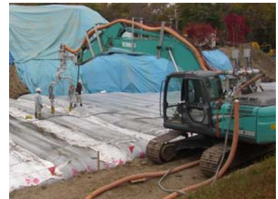
写真一 3 充填装置
