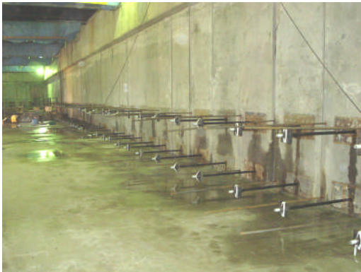
写真－3 鉄筋・P C 鋼棒設置状況
