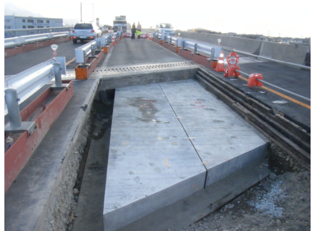
写真－５ プレキャスト踏掛版設置完了
