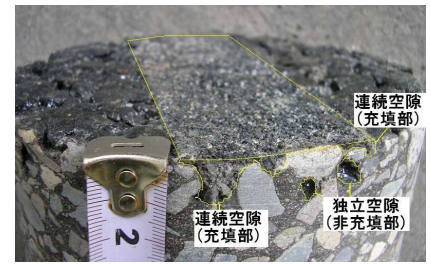
写真－２ 抑制材充填状況
