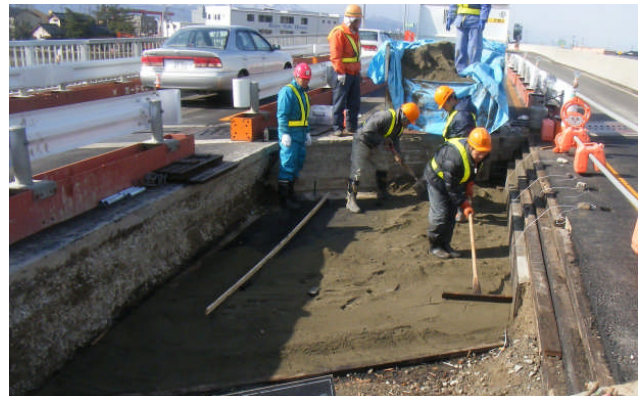
写真－3 敷きモルタル施工状況（踏掛版設置）
