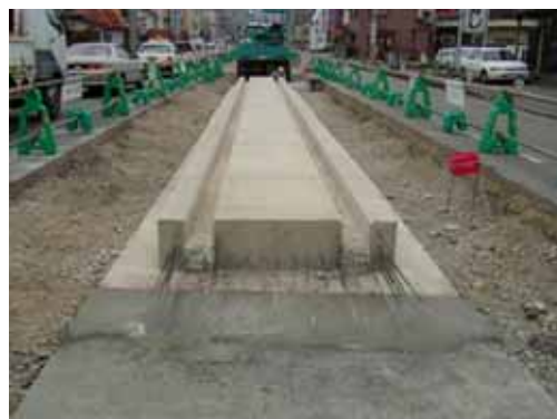
写真-2 現場打ち軌道の完成(富山)
