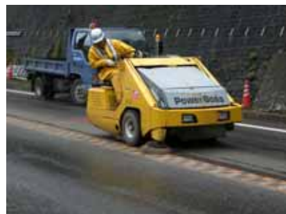
写真－5 廃材撤去
