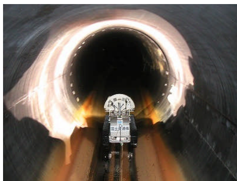
写真-10 管内調査
