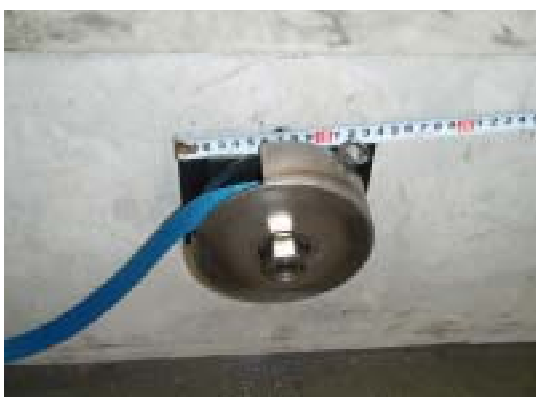
写真-8 専用引き寄せ金具取り付け状況
