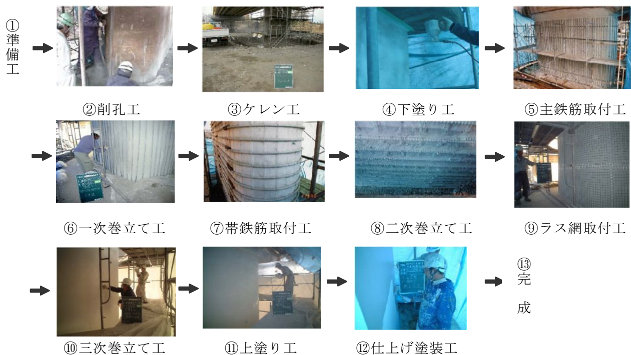
写真-1 施工フロー
