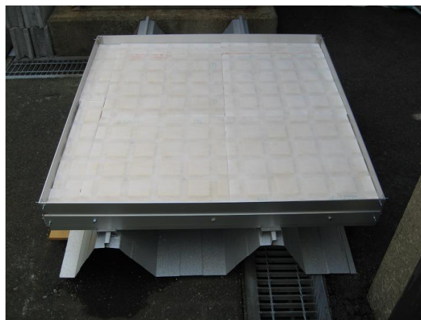
写真2 軽量緑化パネル設置
