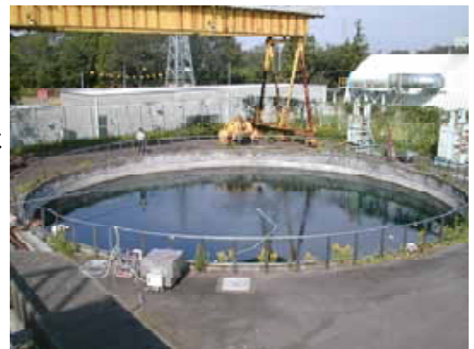
写真－2 水中環境実験施設
