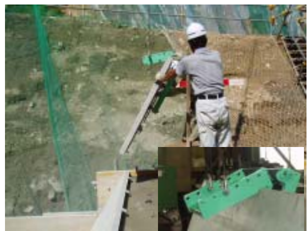
写真－6 専用吊り具
