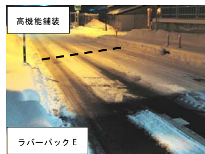
写真－5 降雪時の路面状況
