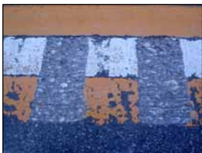
写真－6 清掃後切削面
