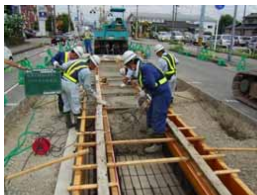
写真-1 コンクリート打設状況(富山)
