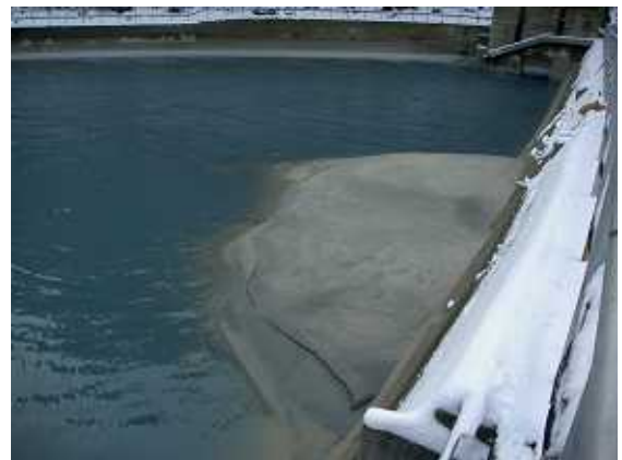
写真-5 排砂口と堆積除去土砂ストック状況
