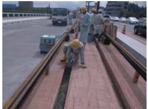
写真-4 レール溝部の清掃 (福井)
