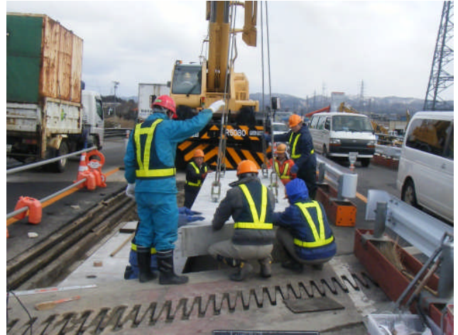
写真－４ プレキャスト踏掛版設置状況
