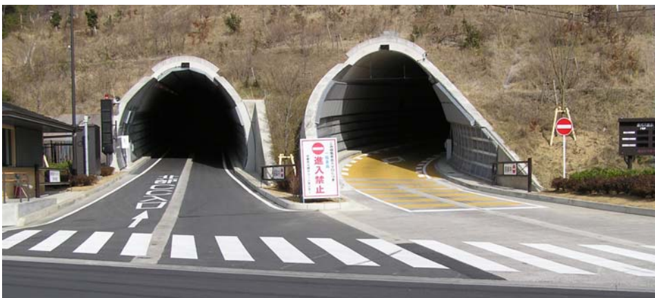
写真-4 施工完成写真（左側：進入路、右側：退出路） （敷地境界付近より）
