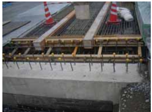
写真-3 レール溝部の型枠・配筋 (福井)
