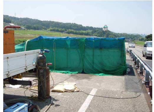
写真-4 はつり防護状況
