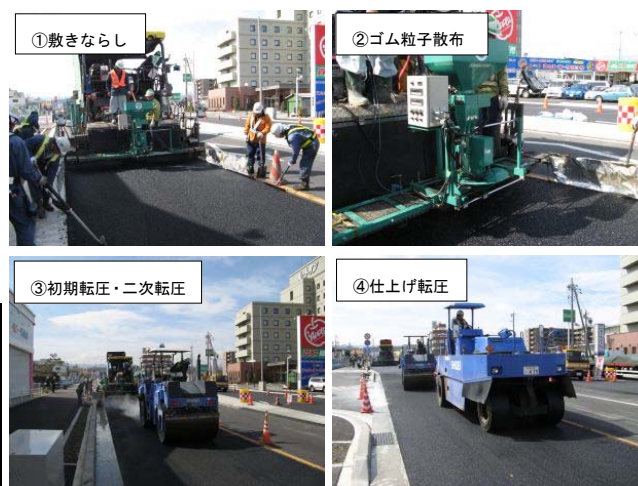
写真－6 ラバーパック Nの施工状況
