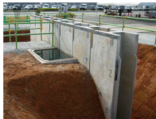
写真－１ 長期低压試験状況
