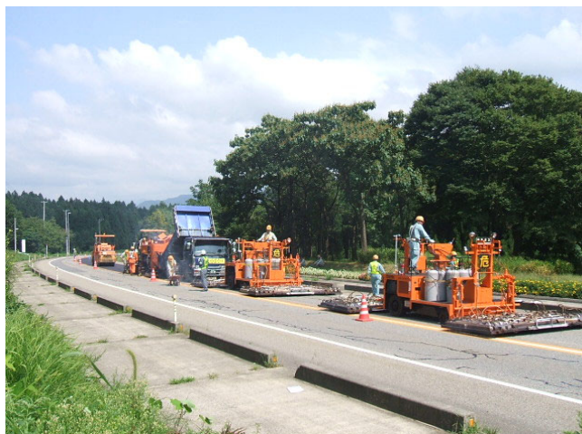
写真-1 施工状況
