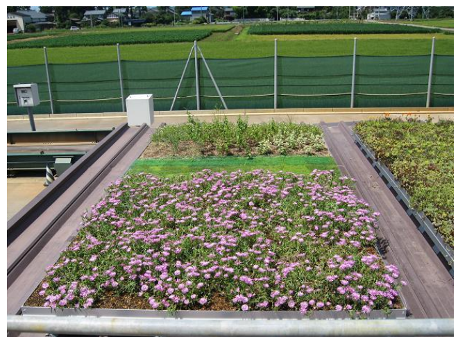
写真8 折板屋根緑化状況
