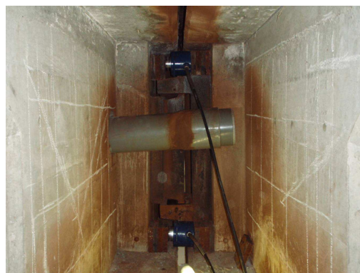
写真-3 中央ヒンジ部仮固定状況
