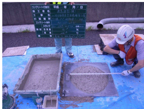
写真-2 高流動コンクリート
