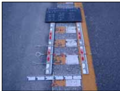
写真－4 出来形測定
