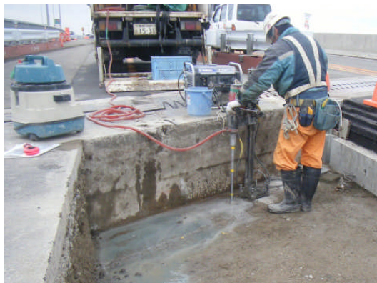
写真－2 アンカー孔削孔状況
