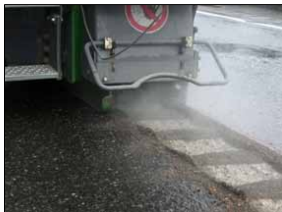
写真－2 切削直後の路面
