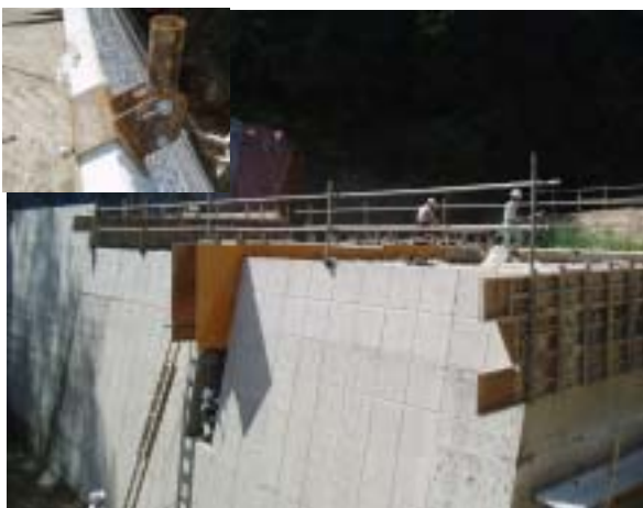
写真－5 転落防止柵
