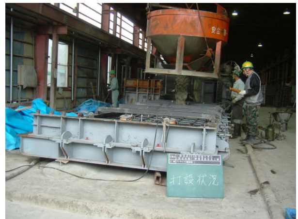
写真－1 プレキャスト踏掛版製作状況
