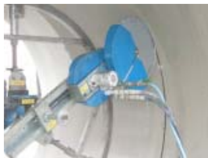
写真－1 誘導目地切削機
