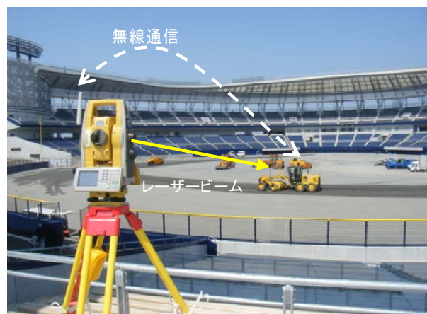
写真－2 TS設置及びMG施工状況
