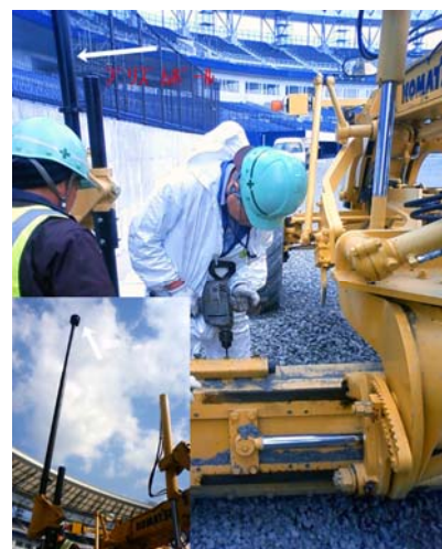
写真－3 プリズムボールの固定
