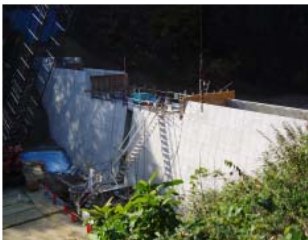
写真-7 現場状況
