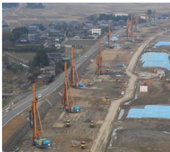
写真-4 施工状況
