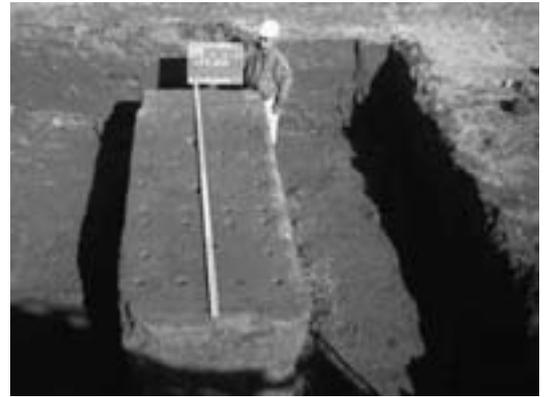
写真-6 実証施工（改良体掘り起こし）
