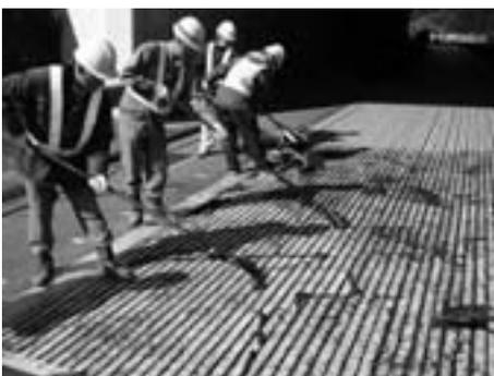
写真-3 抑制材充填
