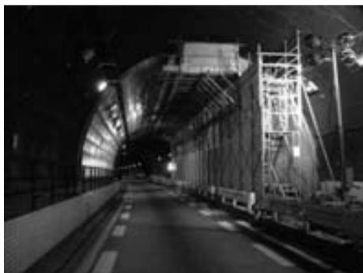
図-11 吊り足場による天端部施工
