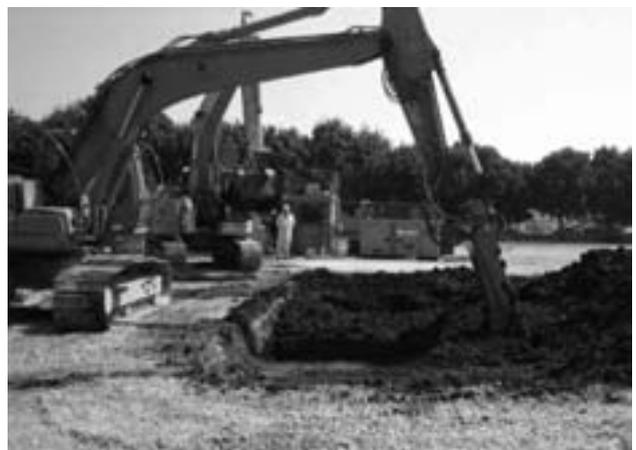
写真－5 汚染土壌の浄化
