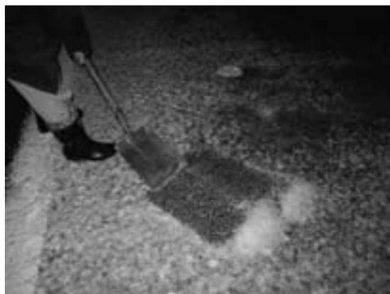
写真-5 バイロメントペーブル上の残雪を剥いだ状況
