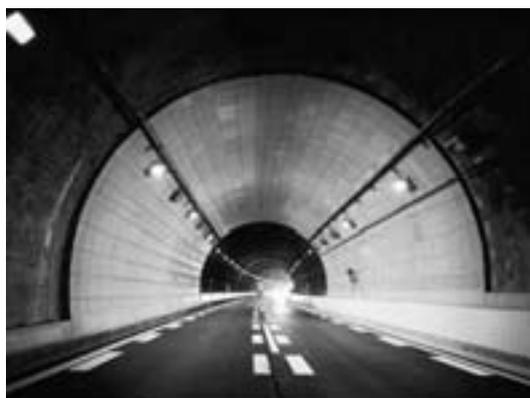
図-12 本工法による内巻補強工
