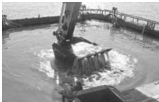
写真-4 バックホウ浚渫工法
