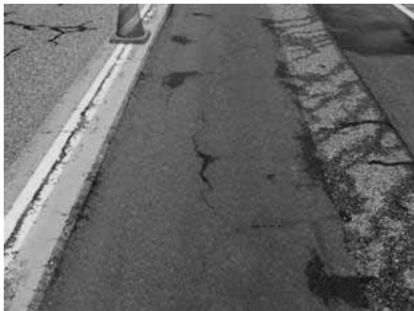
写真-4 わだち部オーバーレイ工法のひび割れ状況
