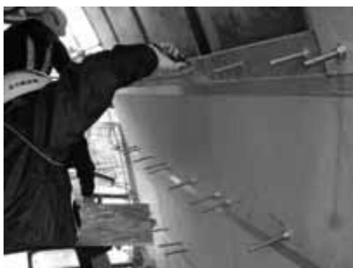
図-8 ボード継手部の接着剤塗布
