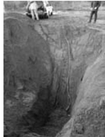
写真-4 土圧計設置状況
