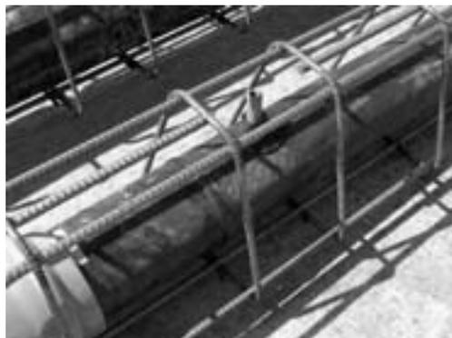
図4 ゴム製枝管継手設置状況
