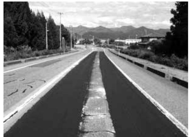
写真-3 わだち部オーバーレイ施工路面状況
