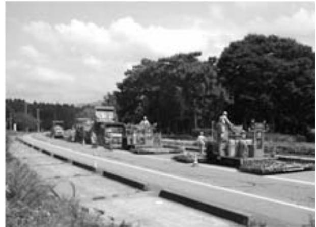
写真-2 ヒートドレッシング工法の施工状況
