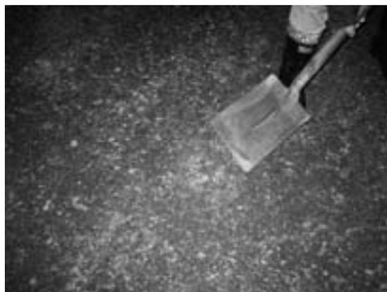
写真-6 密粒舗装の氷を剥いている状況
