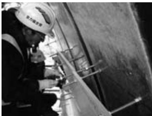
図-7 ボルトによるボード設置
