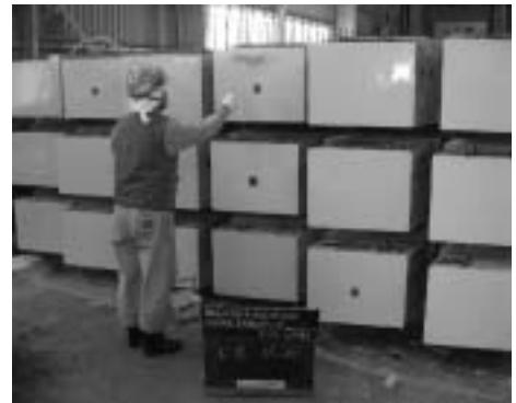
写真-5 桁端部塗装状況
