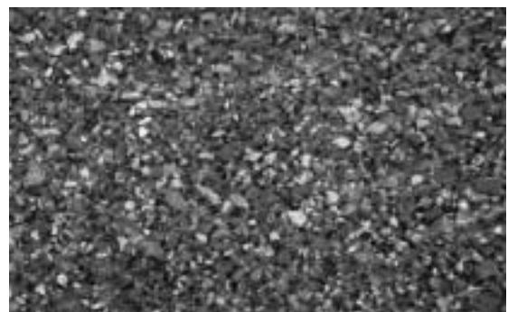
写真-2 路面状況(空隙率17%)
