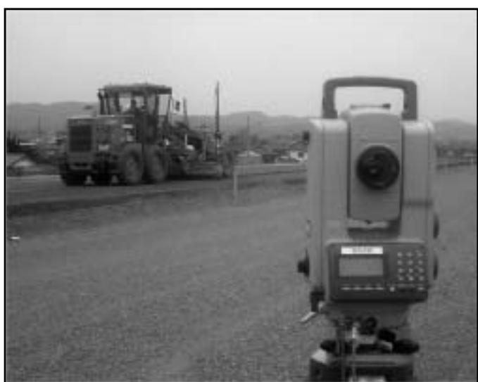
写真-1 TS-3D-MC グレーダの作業状況
