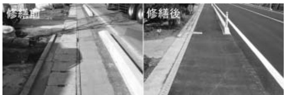
写真-1 リペアリッドによる側溝修繕状況
