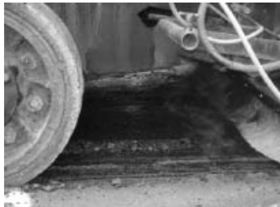
写真-2 アスファルト乳剤散布状況
