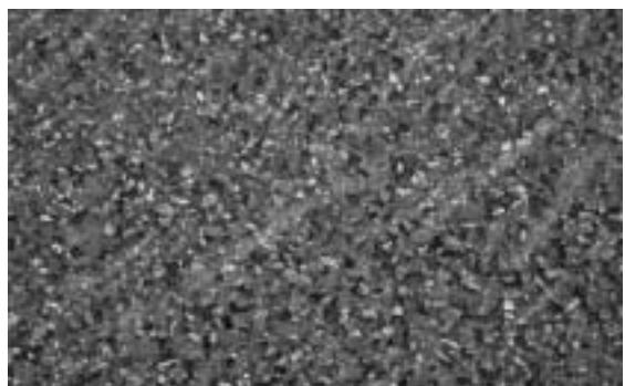
写真-3 路面状況(空隙率10%)
