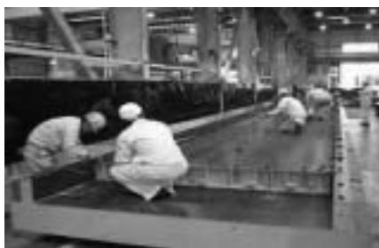
写真-4 PRC版の鋼製型枠
